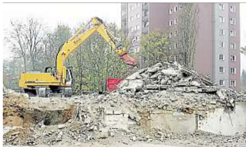
Bagger und Schutt: Bereits 2005 wurde das Kleine Zentrum abgerissen. Der Bau des Seniorenwohnheims war damals schon geplant.
